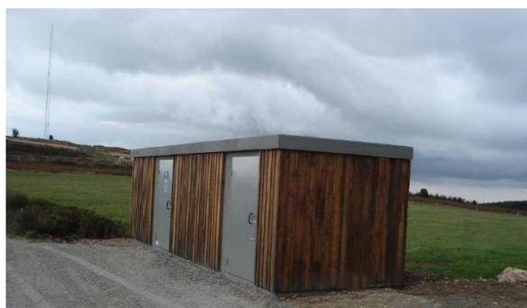
Figure 5 : Exemple d'un poste de livraison avec bardage bois
